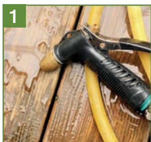
Dřevěný povrch navlhčete.
