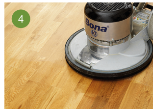
După 1 oră faceți șlefuirea intermediară cu Bona FlexiSand.
