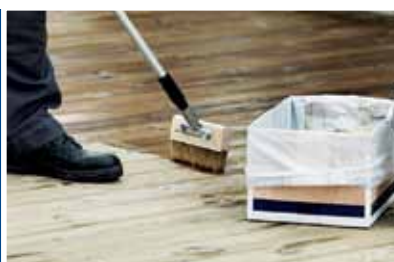
Appliquer Bona Decking Oil avec une brosse
