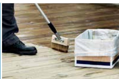
Breng Bona Decking Oil aan met een borstel
