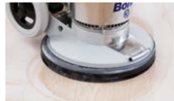
Lijado en seco
