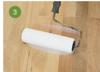
3 Mit einer Bona Rolle die erste Schicht Bona Mega ONE auftragen.
