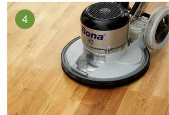
4 Nach nur einer Stunde einen Zwischenschliff mit der Bona FlexiSand durchführen.
