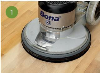
1 Den Boden mit der Bona FlexiSand oder Bona Belt anschleifen.
