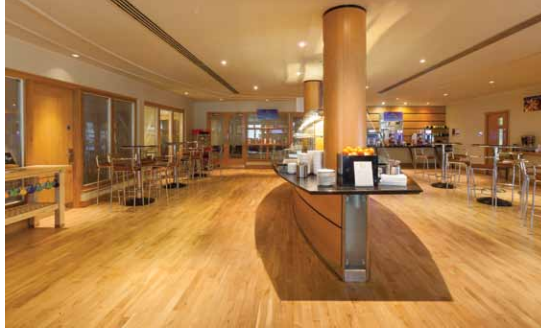
Grondlak Bona Intense zorgt voor een subtiele verdieping van de houtnerf op deze vloer, die is afgewerkt met Bona Traffic HD Anti-slip
