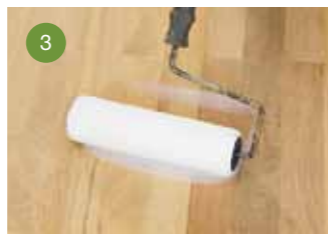
3 Gebruik een Bona Roller en breng de eerste laag Bona Mega ONE op.
