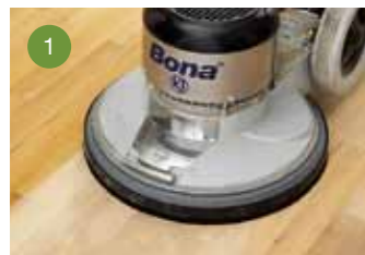
1 Schuur de vloer met de Bona FlexiSand of de Bona Belt.
