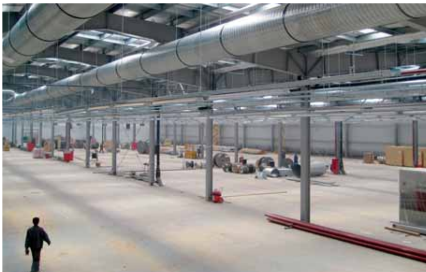
Las obras progresan en la nueva fábrica de parquet en Kaluga
