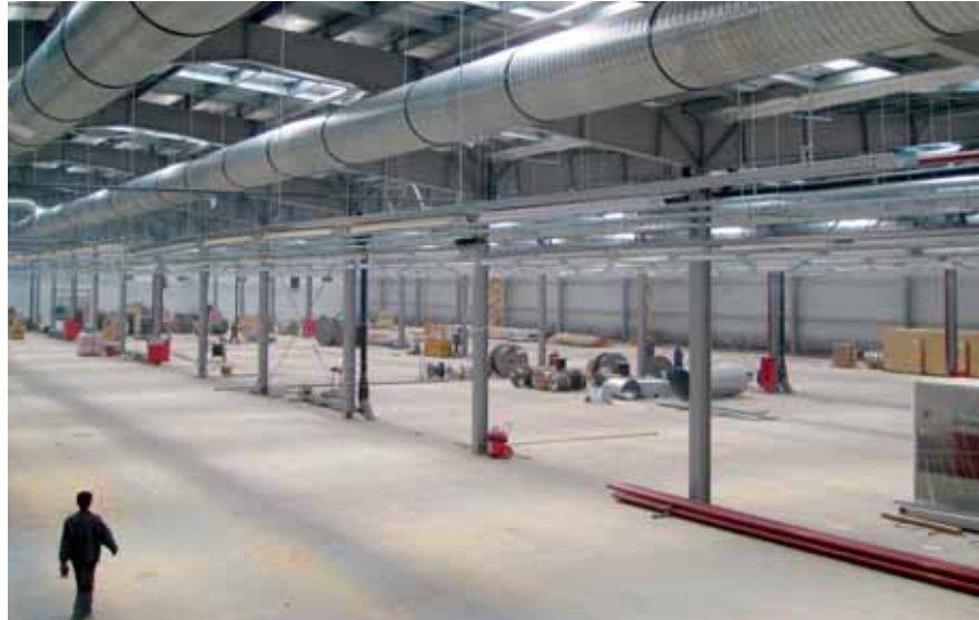
Die Arbeit an der neuen Parkettfabrik in Kaluga schreitet voran.
